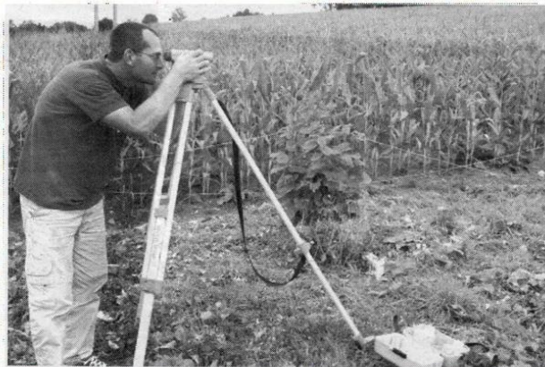
Nicolas Maltrait prend des relevés de niveau pour l'installation d'une piscine biologique chez un particulier.
