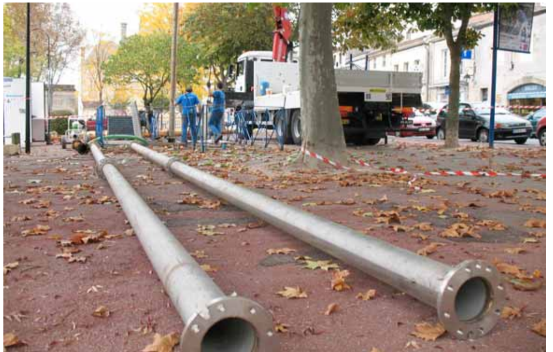
En 2023, la gestion de l'eau et de l'assainissement dans le périmètre de la Métropole devrait être prise en main par une régie publique. ILLUSTRATION ARCHIVES « SUD OUEST »
