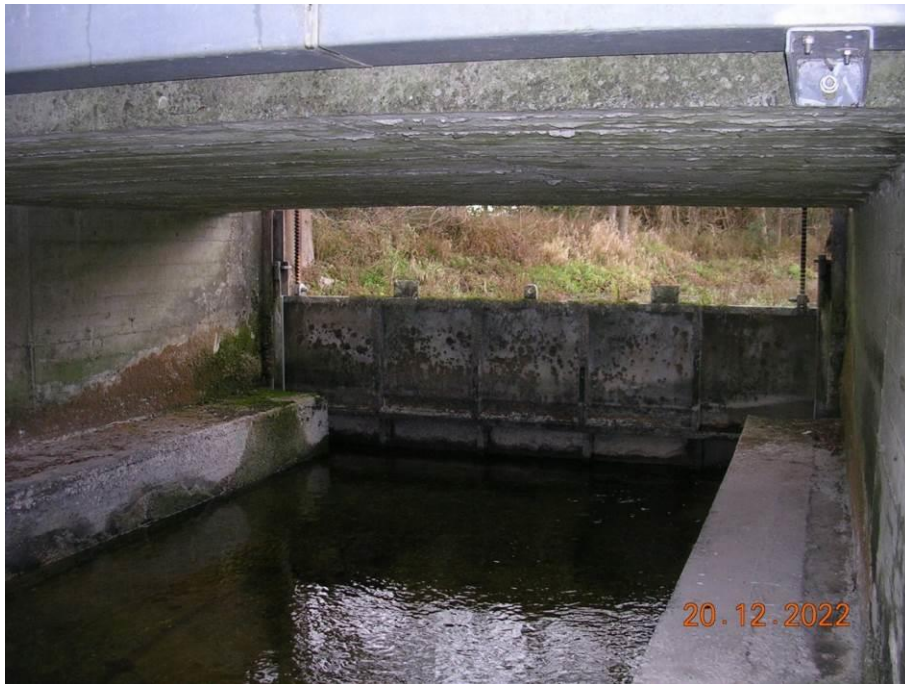
Le Mignon au barrage de Rançon
