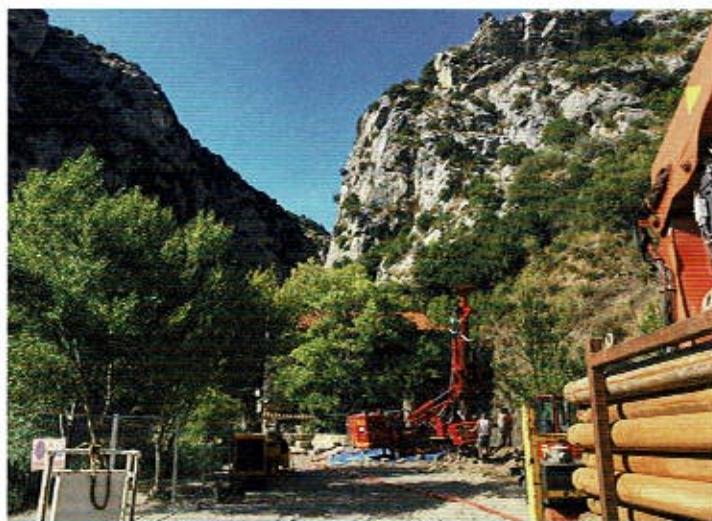
Forage de reconnaissance près du Verdoubie à Tautavel
